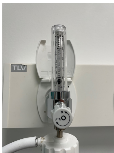
Photo 7 – Le débitmètre est réglé à 0,5L/Min durant le test de fuites
